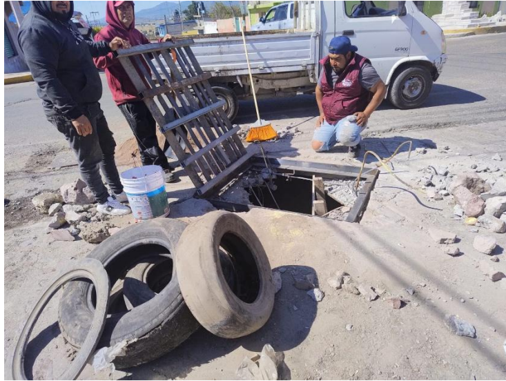
Arreglo de coladera Av. 18 de Marzo 1
