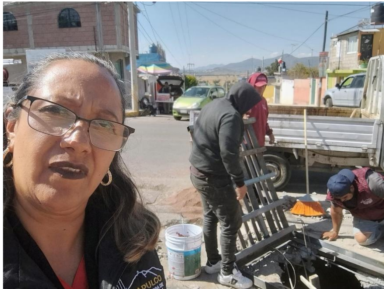
Arreglo de coladera Av. 18 de Marzo 2
